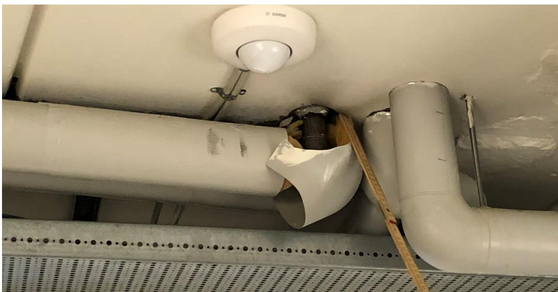
Figur 2: Manglende brandtætning ved installationsgennemføring i kælder/underetage
